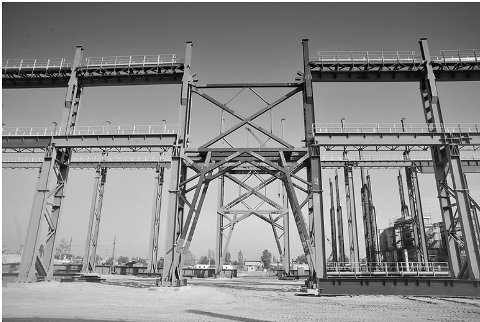
Stahlbau von „Interpipe“
